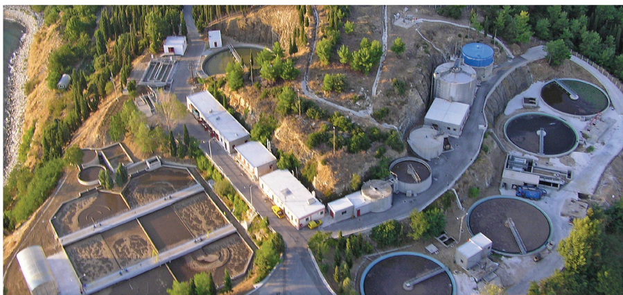
Επεξεργασία λυμάτων Καβάλας
