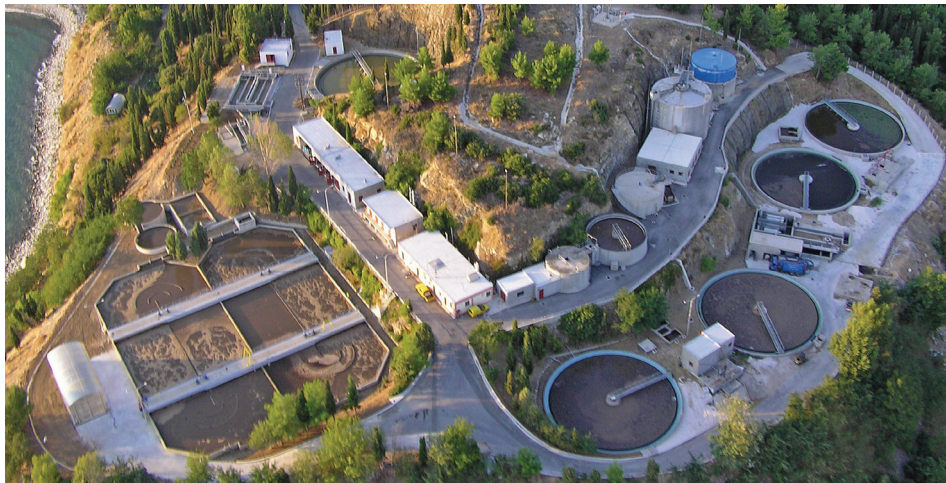
Επεξεργασία λυμάτων Καβάλας
